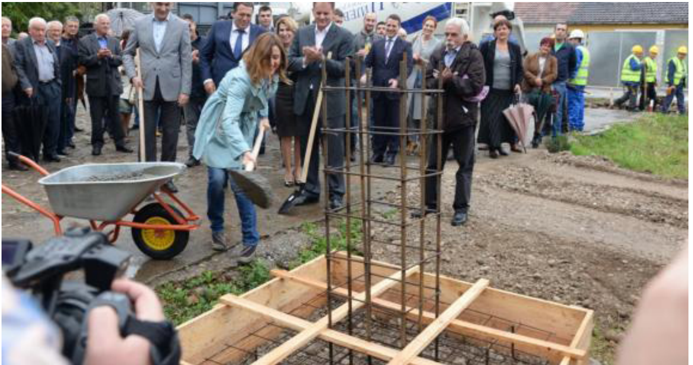
Detalj sa polaganja kamena temeljca zgradi Gradskog pozorišta
