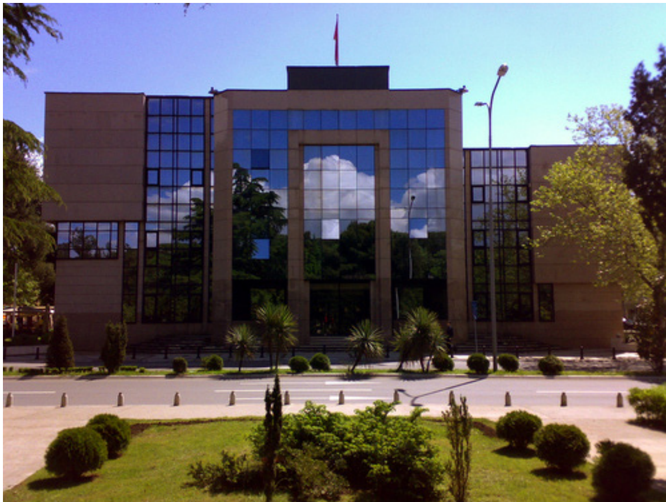
Dvadeset godina CNP u novoj zgradi
