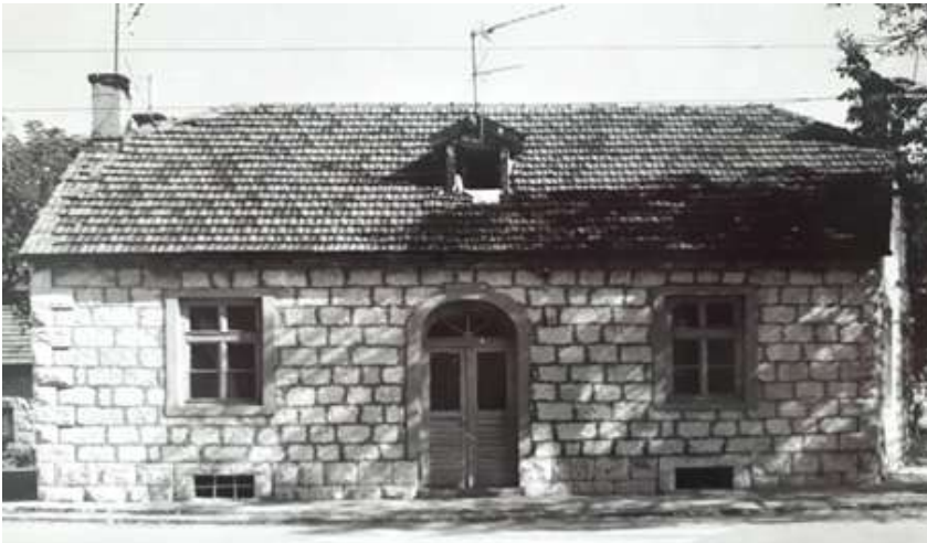
Stara zgrada Muzičke škole
